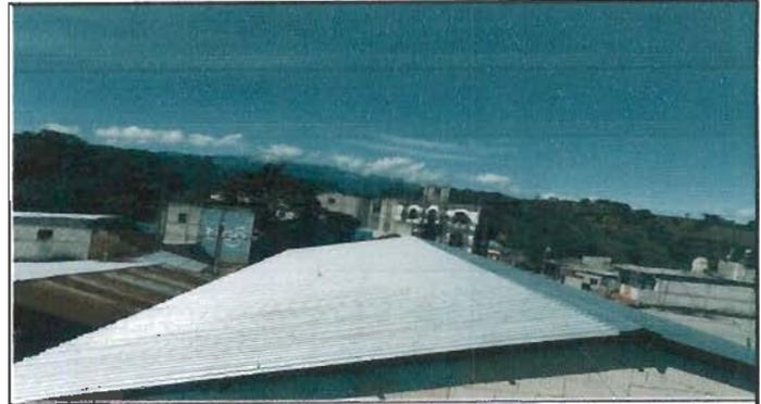
Foto 6: Sustitución de lamina por lamina troqueleada aluzinc calibre 26
